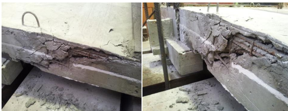
Рисунок 7 – Образование наклонных трещин и разрушение продольного ребра плиты
