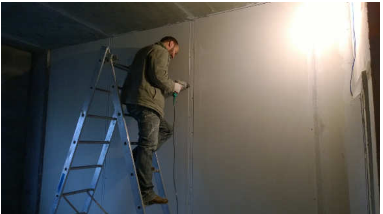
Рисунок 8 – Монтаж дополнительных внешних листовых облицовок на перегородку (размер 3,9 м × 2,5 м) из сэндвич-панелей при испытаниях звукоизоляции в натуральных условиях
