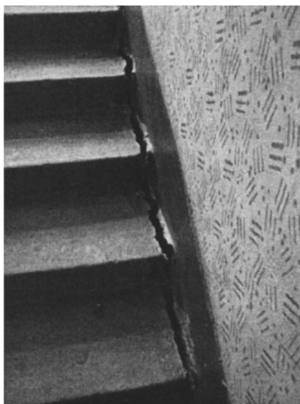
Рисунок 5.2.1 – Общий вид узла примыкания лестничного марша к несущей стене лестничной клетки (образовавшийся зазор между конструкциями - до 20 мм)
